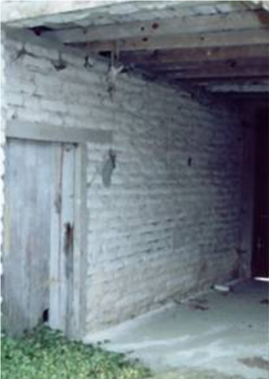
Pátio coberto e porta da casa de arrumação
